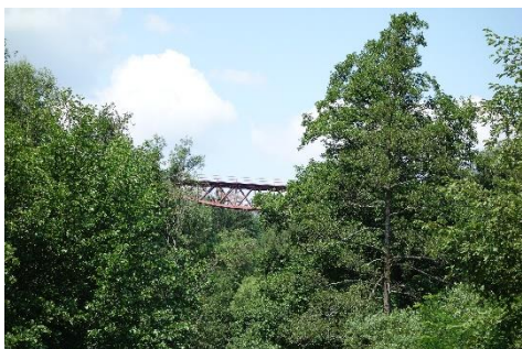
Železniční ("Eiffelův") most na trati do Radnic
