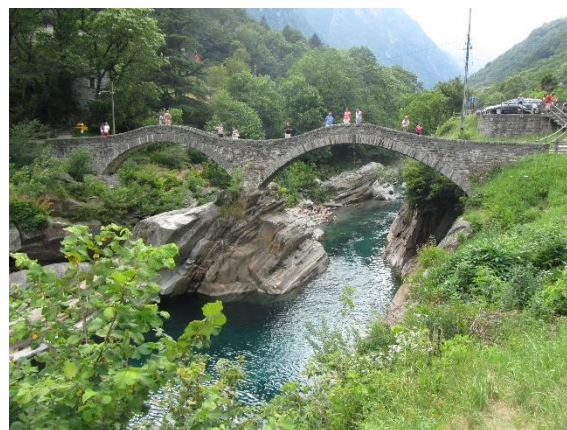
Most přes Verzasku v Lavartezzu
