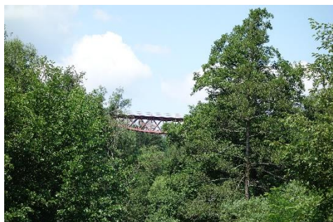
Železniční ("Eiffelův") most na trati do Radnic
